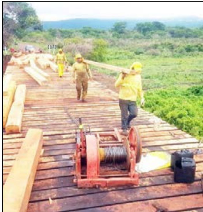
Obra ajuda no escoamento da produção e melhora o acesso (Arquivo)
