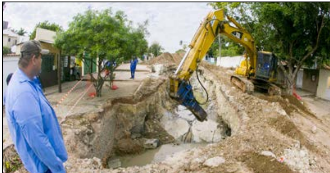
Obras estão concentradas no cruzamento das ruas Luiz Feitosa Rodrigues e América (Foto: Clóvis Neto)
